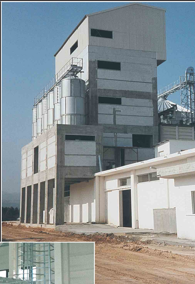
Silos cereali in lamiera ondulata, silos materie prime in lamiera grecata, celle prodotti finiti in lamiera liscia in un impianto completo di linee di cubettatura e di estrusione (Grecia) / In Greece, corrugated sheet metal grain silos, fretted sheet metal raw material silos, smooth sheet metal finished product bins in a plant complete with pellet milling and extrusion lines
